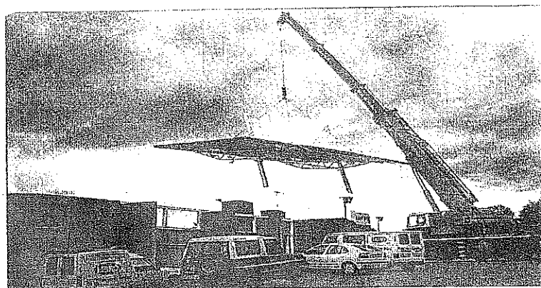
Una grúa va recol·locar la coberta del camp de futbol de la Garriga
