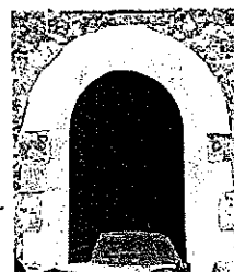
Portalada d'entrada a la casa.
