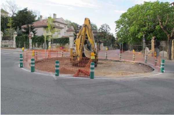
1. Inici dels treballs.
