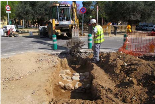
3. Realització de la rasa núm2.
