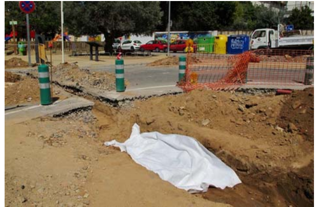
4. Protecció i cobriment del mur.
