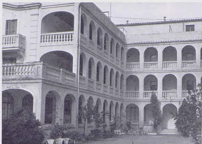
Fachada sur. Aspecto parcial.
