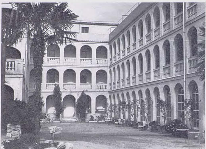
Fachada sur. Otro aspecto.
