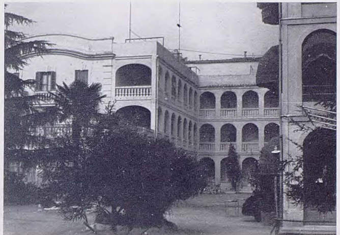
Fachada sur. Galerías del patio.
