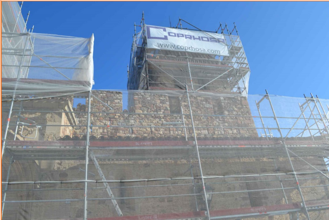
Foto 2. Vista general de la façana sud durant les obres.
