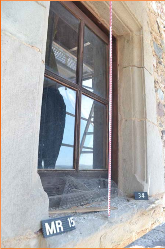
Foto 13. Façana sud del sobrealçat del comunidor. Detall de la finestra UE 34.
