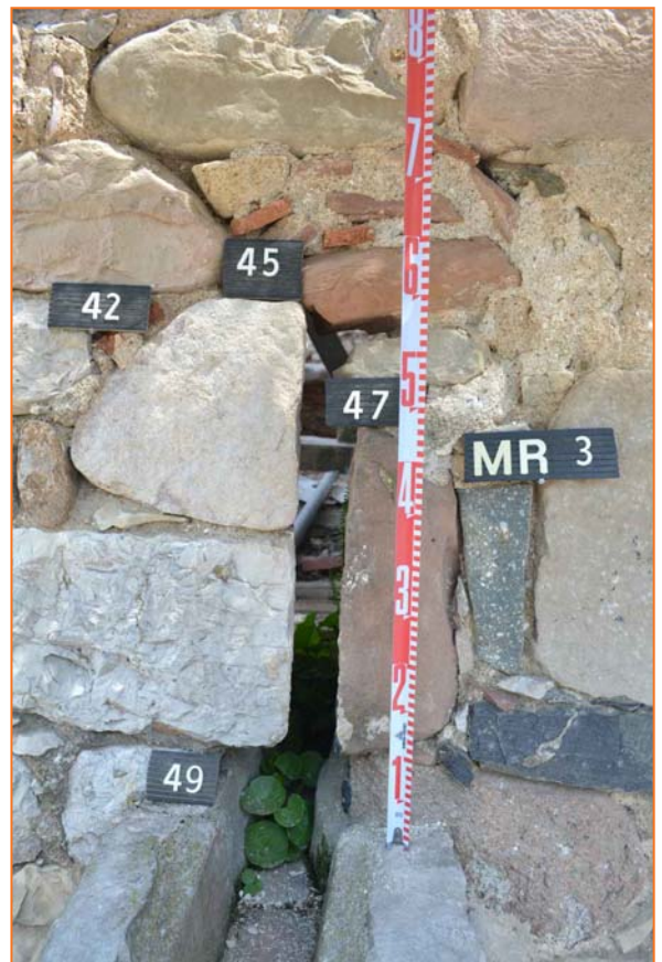
Foto 10. MR-3. Espitllera (UE 45) reformada (UE 47) i desguàs (UE 49) fet a la fase 10.
