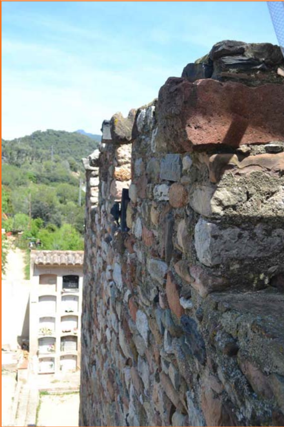
Foto 9. MR-3. Detall dels merlets amb els garfis pels mantellets.
