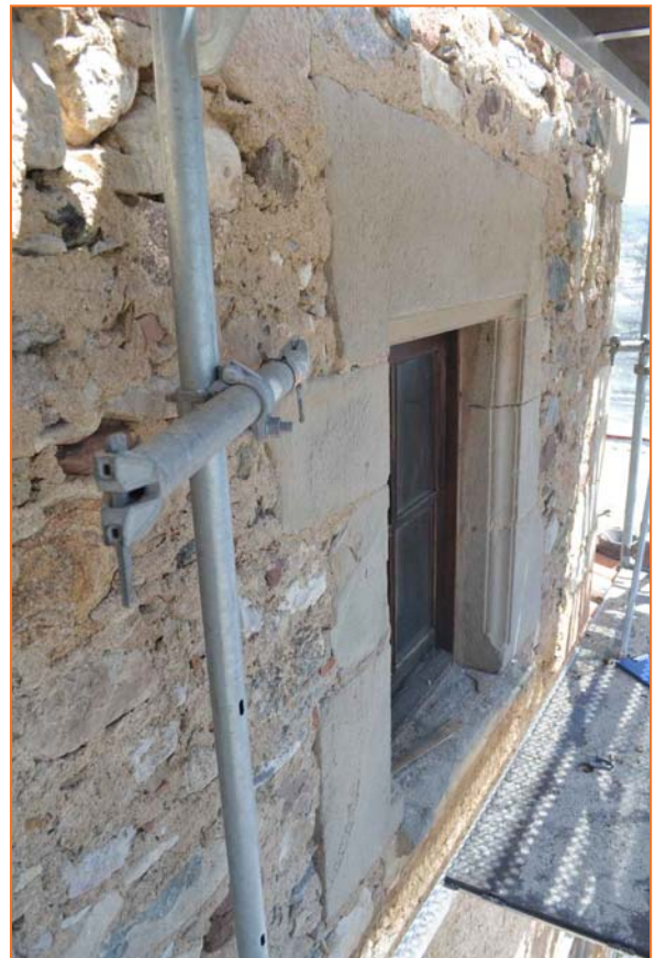
Foto 14. Façana sud del sobrealçat del comunidor. Detall de la finestra UE 34.
