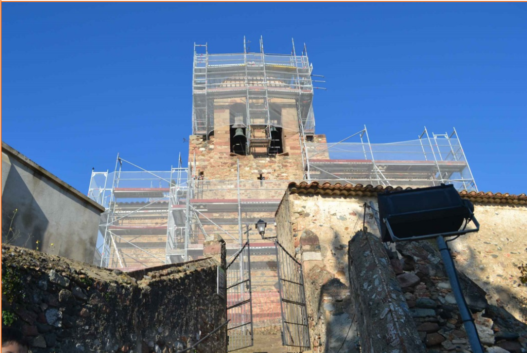
Foto 1. Vista general de la façana est durant les obres.
