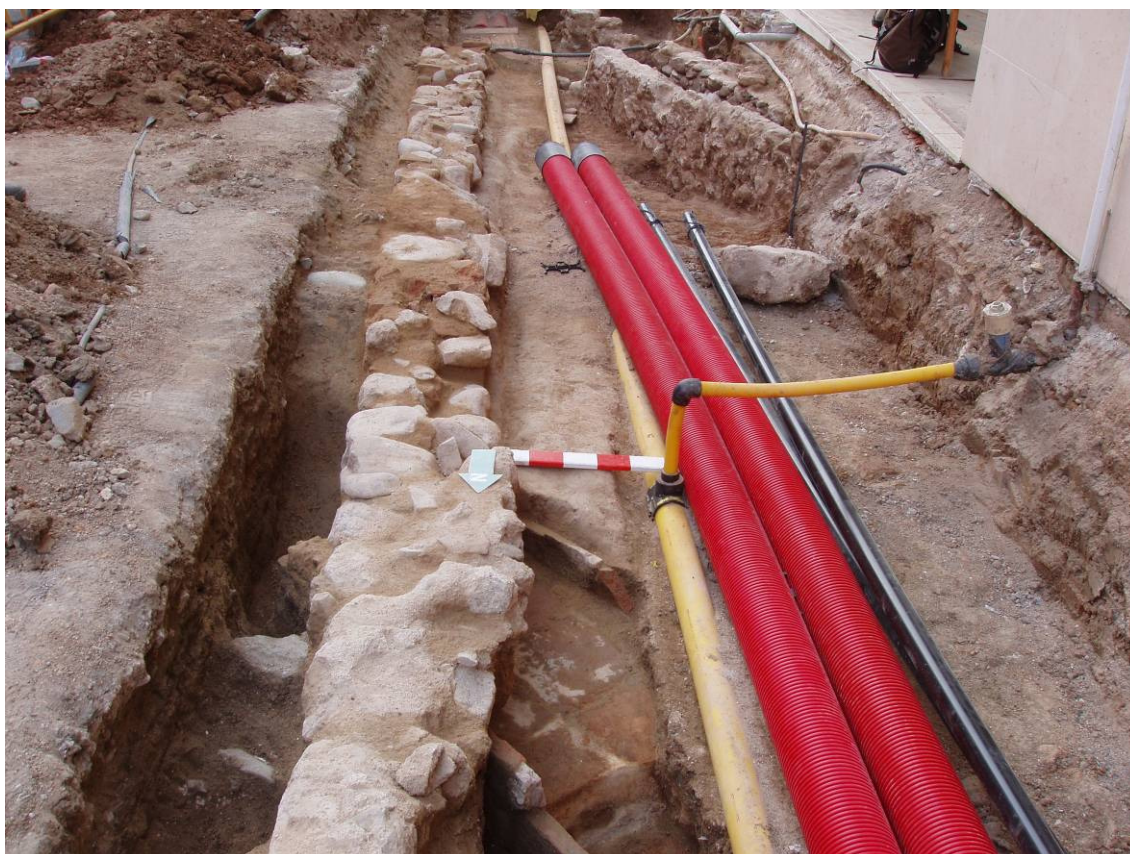
Imatge de la estructura 226
