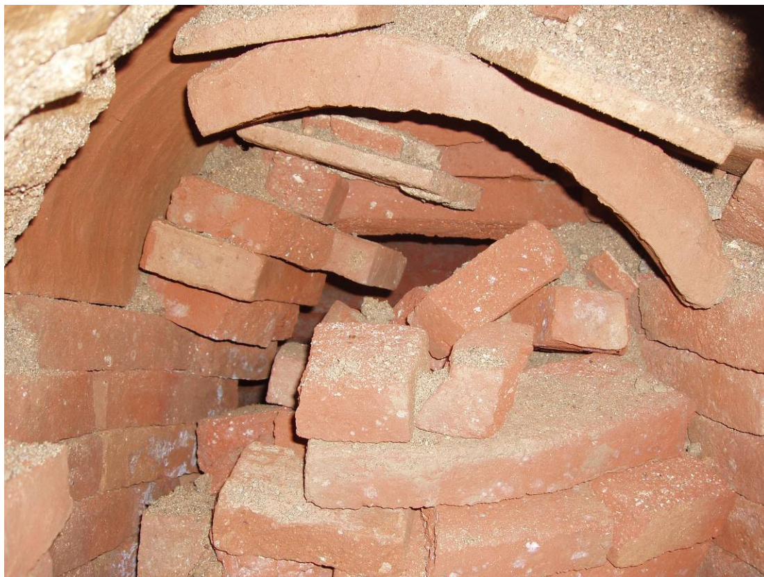
Vista de part de l'interior de la estructura 152
