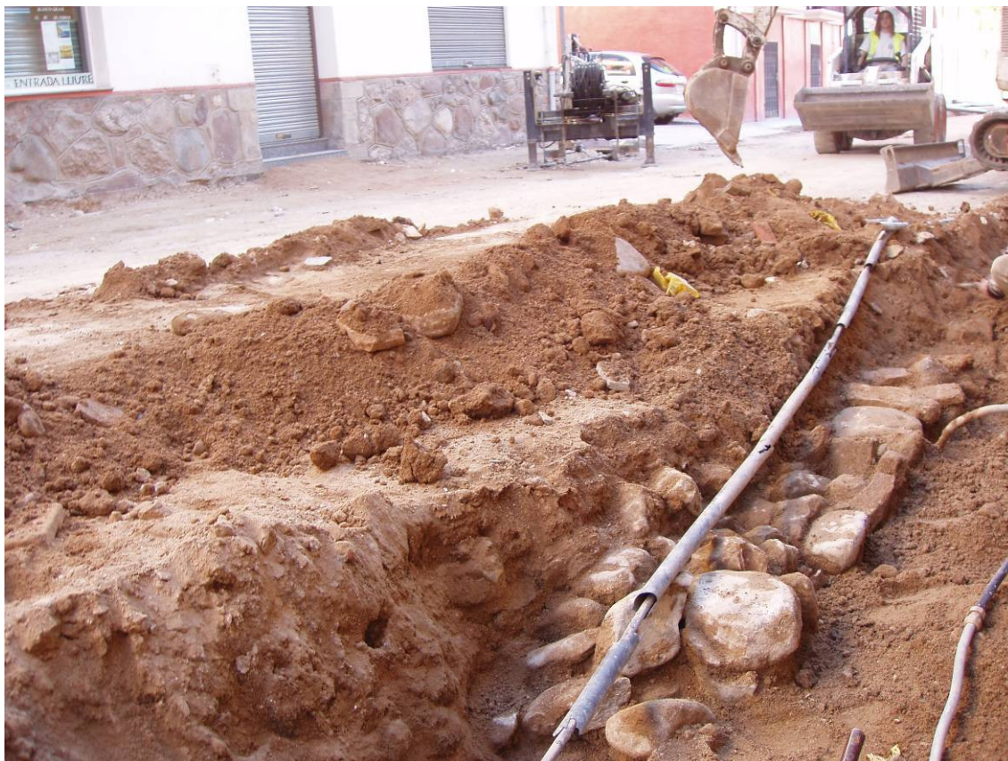
Imatge de la estructura 193 durant la seva delimitació
