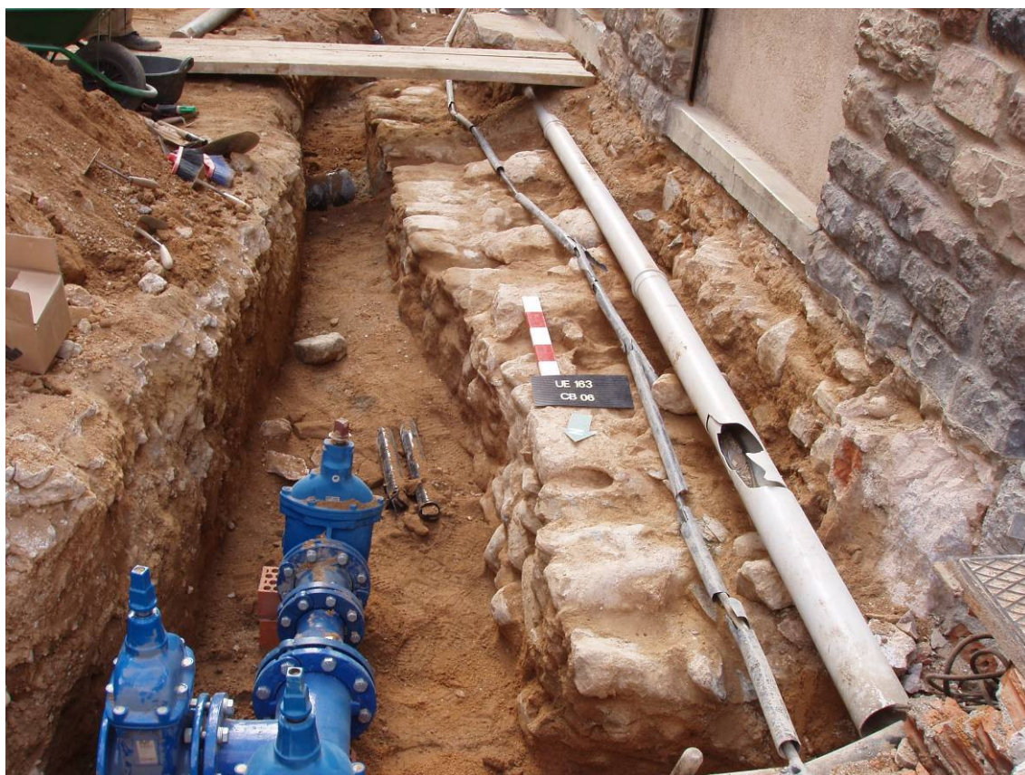
Imatge de la estructura 163
