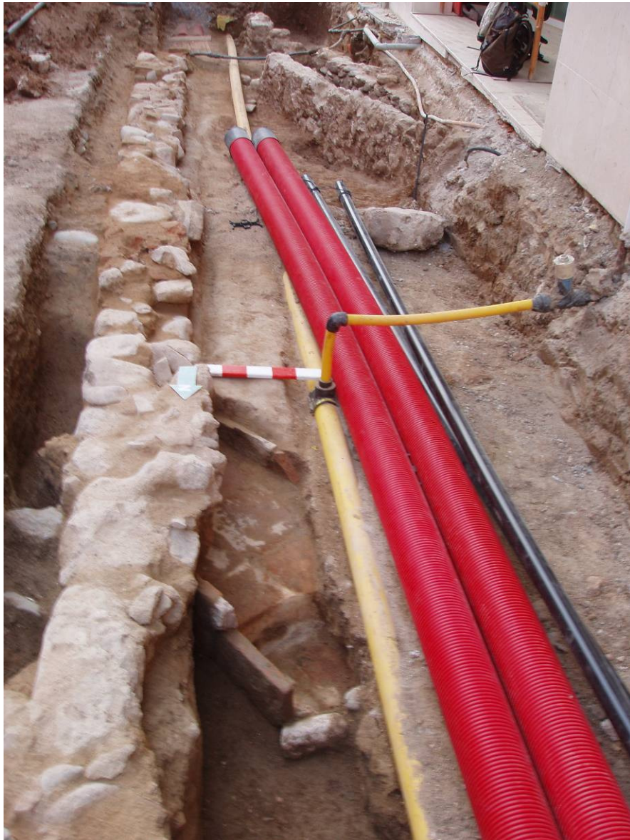
Imatge de la estructura 248
