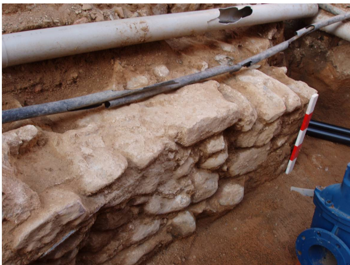
Detall del parament de la estructura 163
