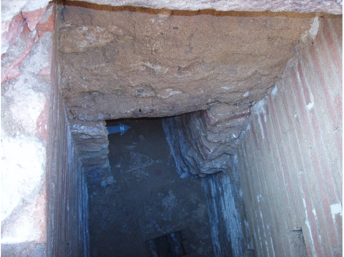
Paret interior est del dipòsit.
