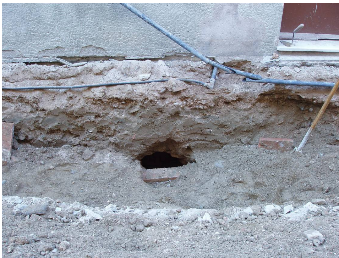
Imatge en el moment de l'aparició de la estructura 152, a nivell de fonamentació de l'edifici núm. 44.
