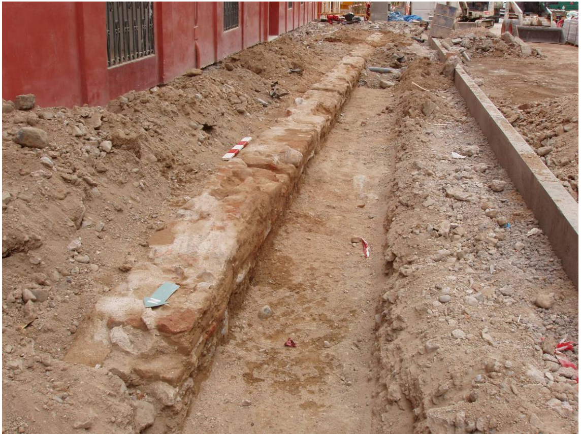
Imatge de la estructura 400
