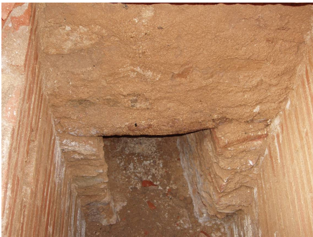
Paret est del dipòsit amb imatge de la entrada en direcció a l'interior de Can Raspall.
