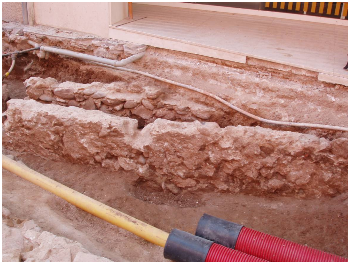
Imatge de la cara exterior del mur 238.
