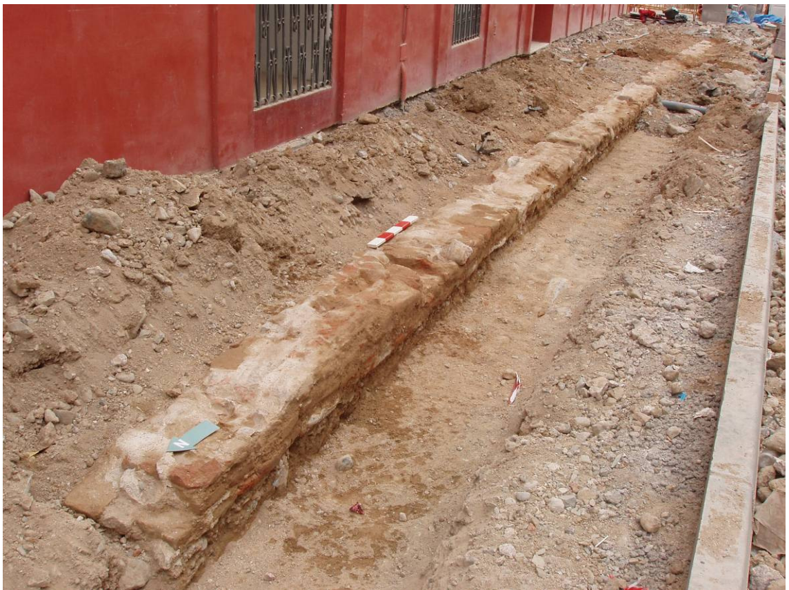
Imatge de la estructura 400
