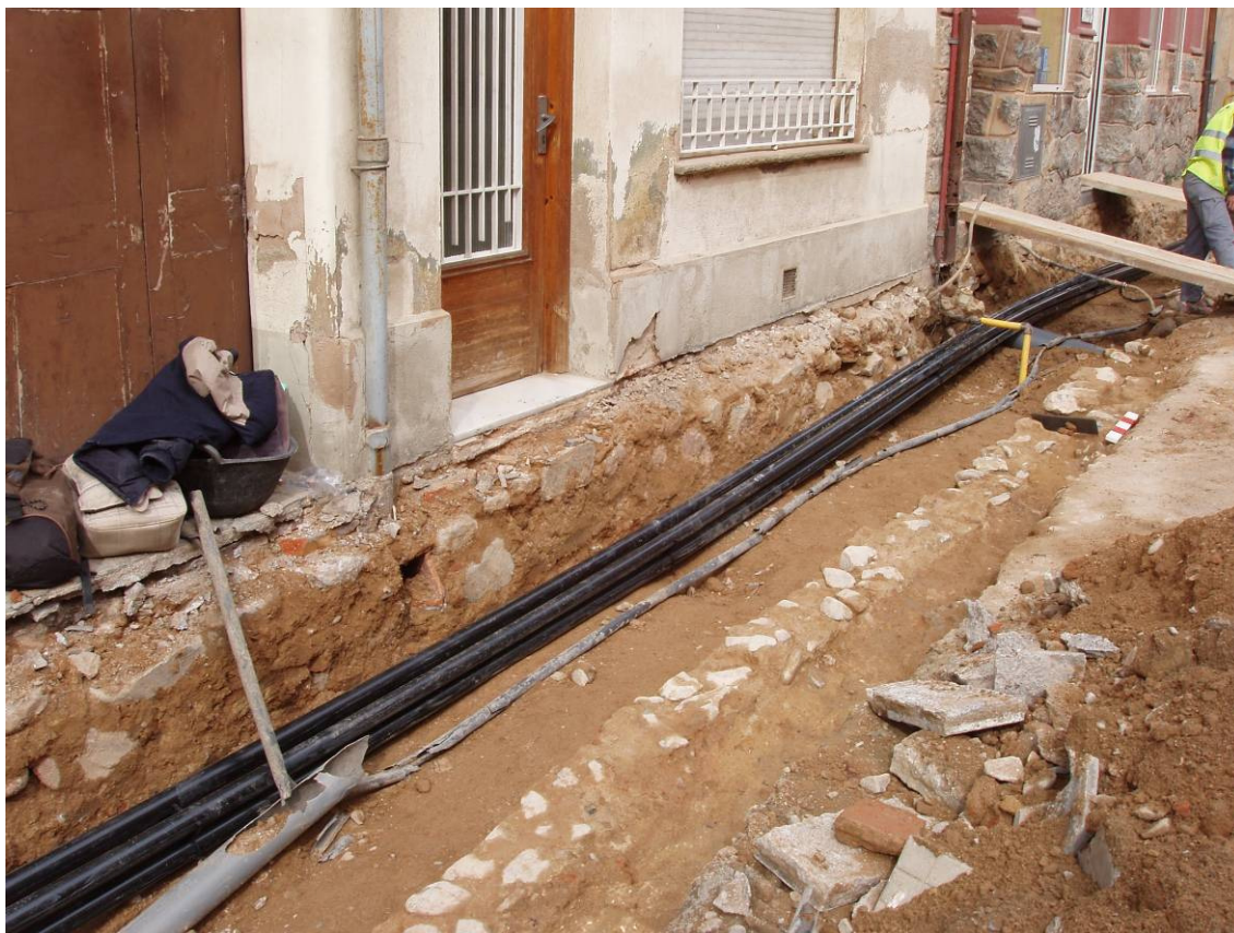
Imatge de la estructura 191
