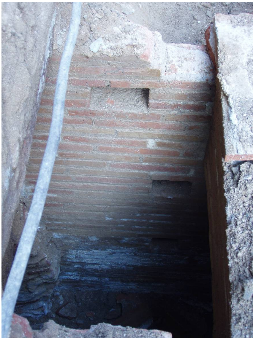
Paret interior nord del dipòsit.
