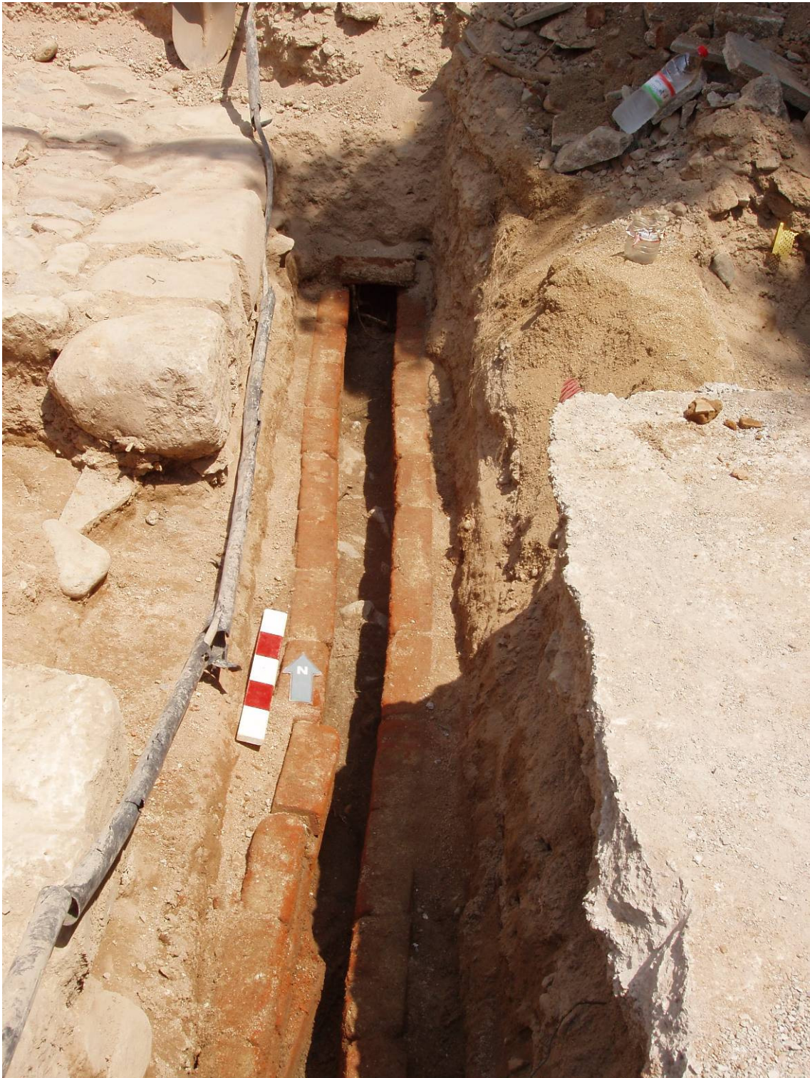
Imatge de la canal 263 després de la extracció de la seva coberta
