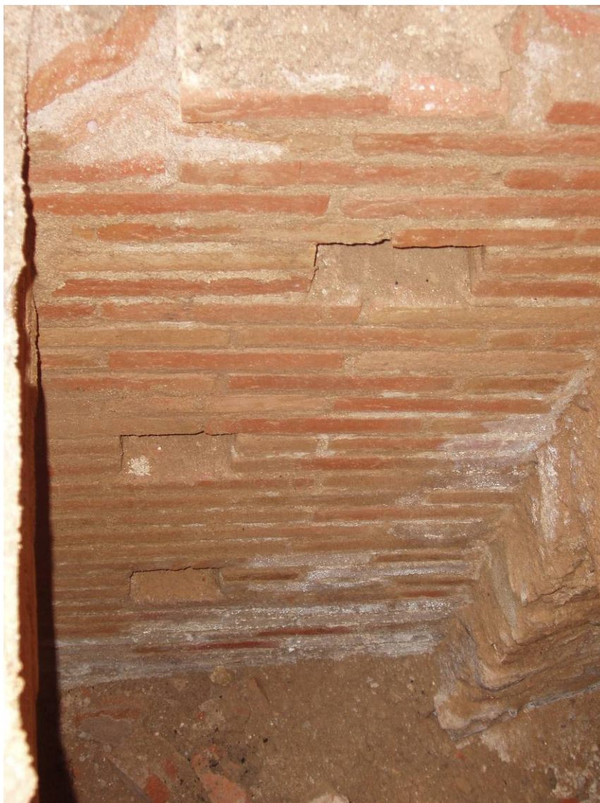
Paret interior sud del dipòsit.
