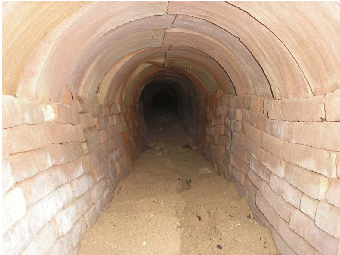
Imatge 7: Interior de la galeria de la mina. Les parets laterals, realitzades amb maons ceràmics, presentaven una lleugera pendent cap a l'interior per tal d'alleugerir la pressió de les parets.
