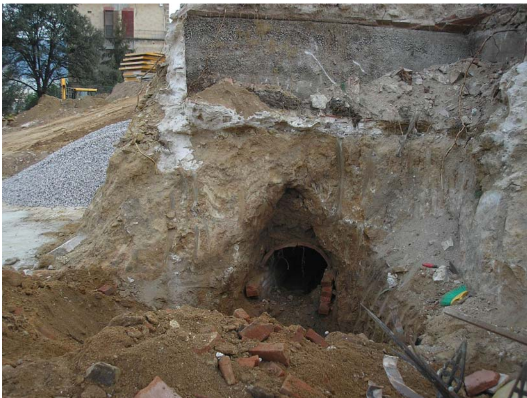
Imatge 3: Inici del procés de neteja de la part que restava visible de la mina. La casualitat de la troballa feu que es trobés seccionada pels treballs de les màquines.
