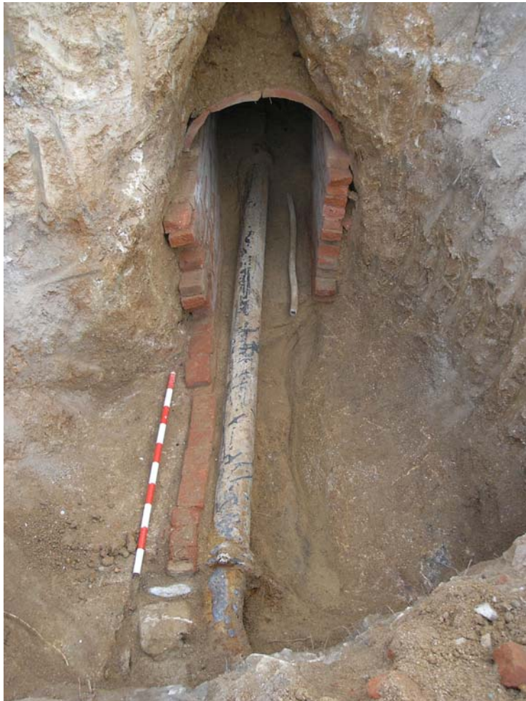
Imatge 4: La mina un cop ja netejada i delimitades les seves estructures i estrats. S'hi observen les dues canalitzacions internes.
