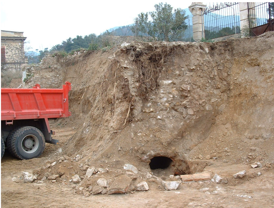
Imatge 1: Estat de la mina en el moment de la seva troballa per part dels tècnics de l'obra.
