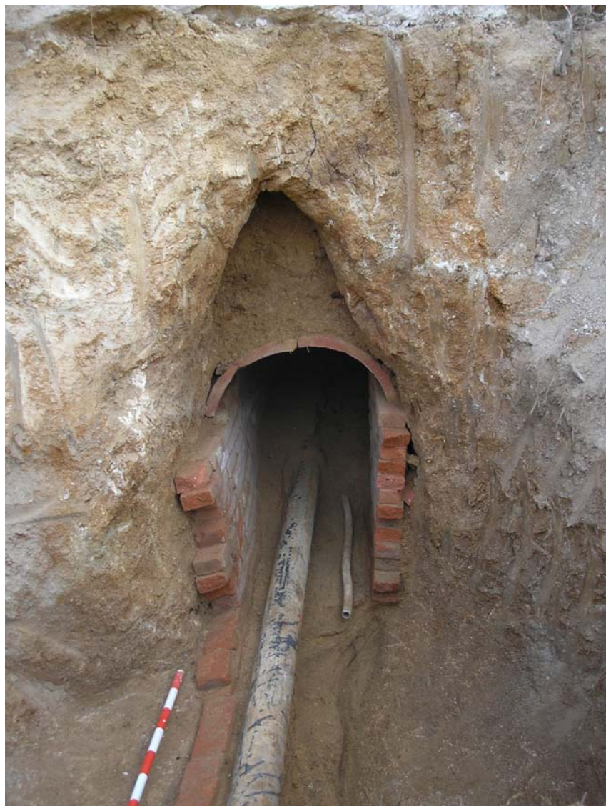
Imatge 5: Sobre la coberta de peces ceràmiques s'observà la part superior del forat perforat per a la construcció de la mina. Aquest fou reblert posteriorment amb pedra i sauló.
