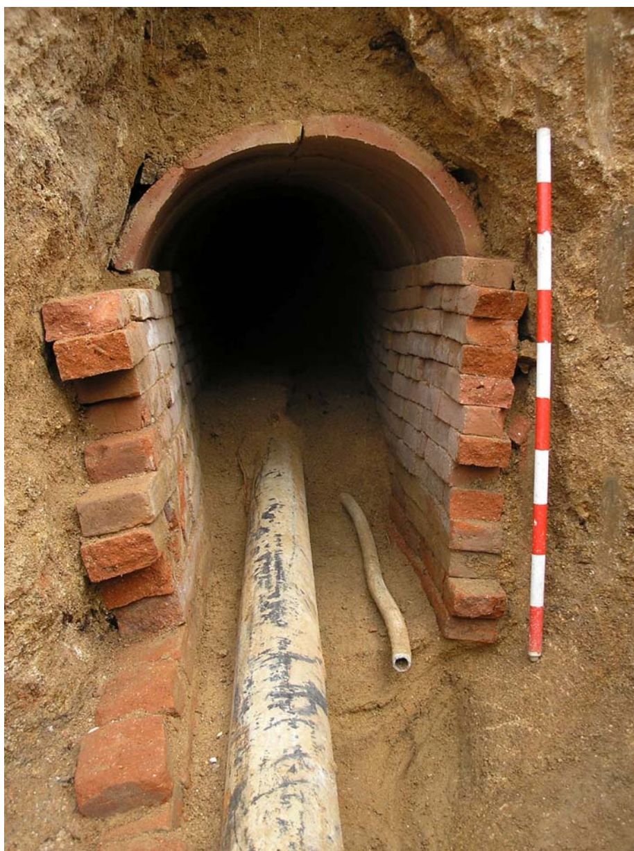
Imatge 6: La coberta era formada per peces de ceràmica en forma de quart de cercle, les quals es recolzaven unes amb les altres formant un semicercle a forma d'arc. Aquestes a la vegada, es recolzaven sobre els murs laterals de maons.
