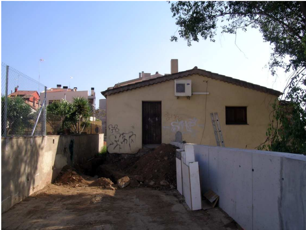
Fotografia 6. Situació del mur UE-48 i de la rasa oberta amb relació a la masia.
