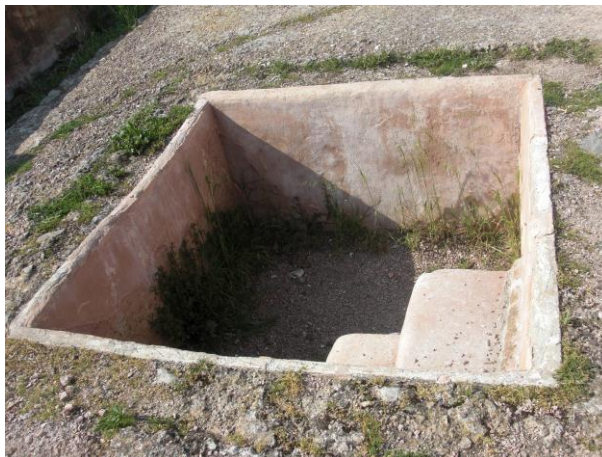
Foto 13. Morters de revestiments relació directe a atacs antròpics
