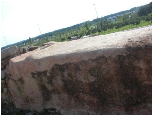
Foto 14–15. Fissures i esquerdes i descohesió
