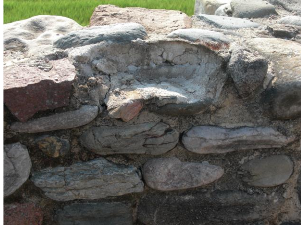
Foto 9-10. Pèrdua element petri i desgregació del morter
