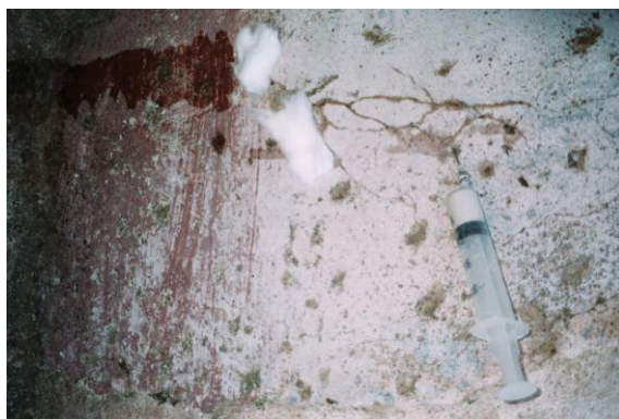
Foto 22. Injeccions per consolidar
