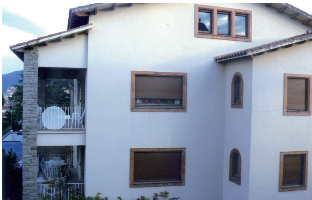
La nova torre de la tia Maria Suñol per als tres fills, a la zona nord-est.
