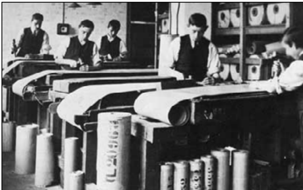
Fig. 6. Fase de picatge manual de les matrius en una empresa londinenca l'any 1911, abans d'introduir-les a la màquina per fer les còpies en sèrie a mida comercial. Font: Pianola Institute.
